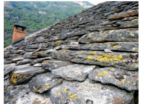
Charakteristisches Granitdach aus alten «Piede»; relativ grosser Unterhaltsbedarf, nur bedingt wasserdicht
