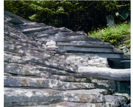
Il riscontro: tetto in piastre di granito squadrate e tagliate; care in fase di costruzione, ma impermeabili e praticamente senza necessità di manutenzione.
